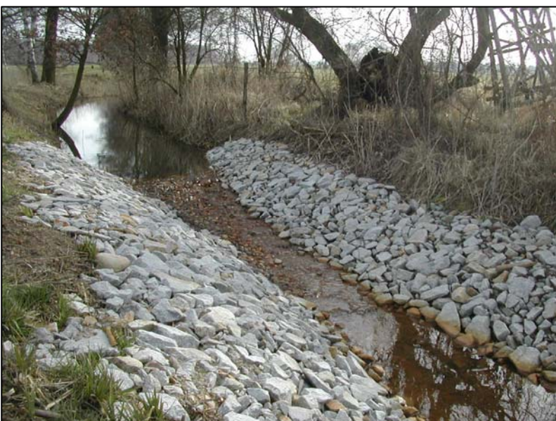
Bild 1: Stützwelle im LC 103-04
